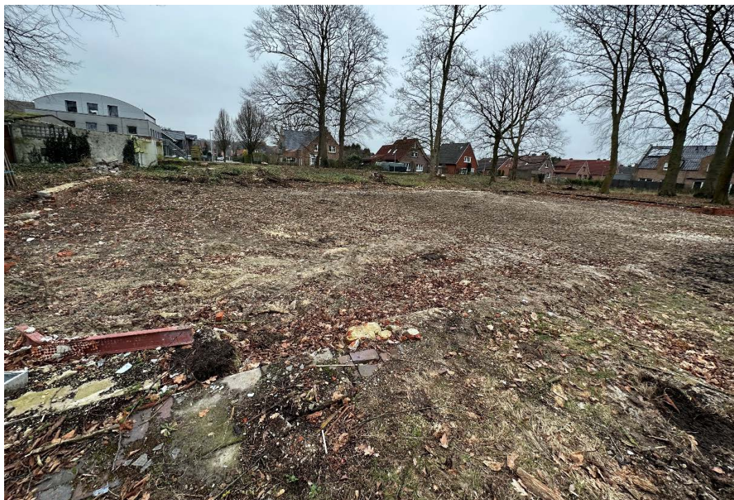
Abbildung 5: Fläche des abgerissenen Saalgebäudes (Fundamente noch vorhanden), Füllsand im Bereich der ehemaligen Bodenplatte
