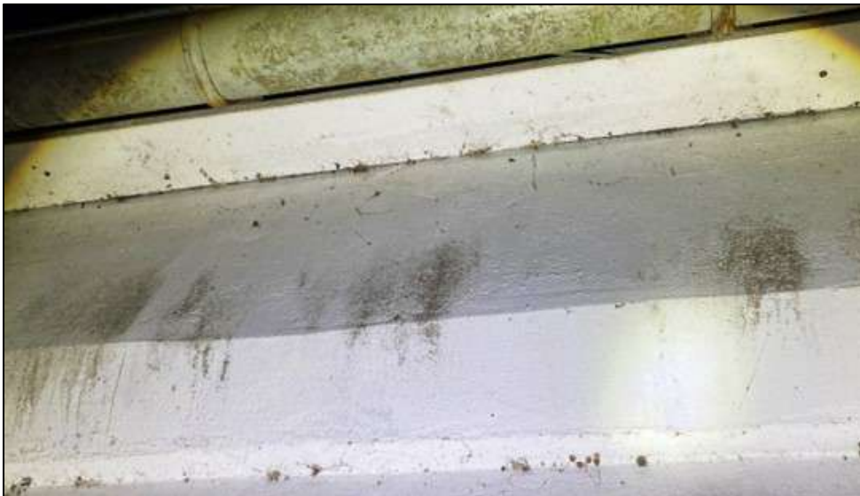
Abbildung 17: Mögliche Fledermausspuren am Gebäude des Schießstandes auf Moorweg-Seite (konnte nicht bestätigt werden).
