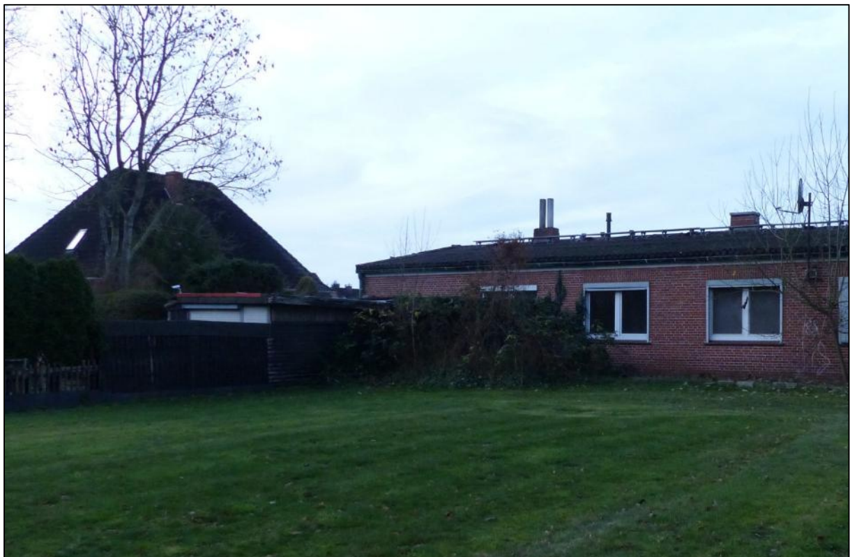
Abb. 8: Angrenzend an Wohngebäude 2 der Schuppen Nr. 5 (s. Abb. 13)
