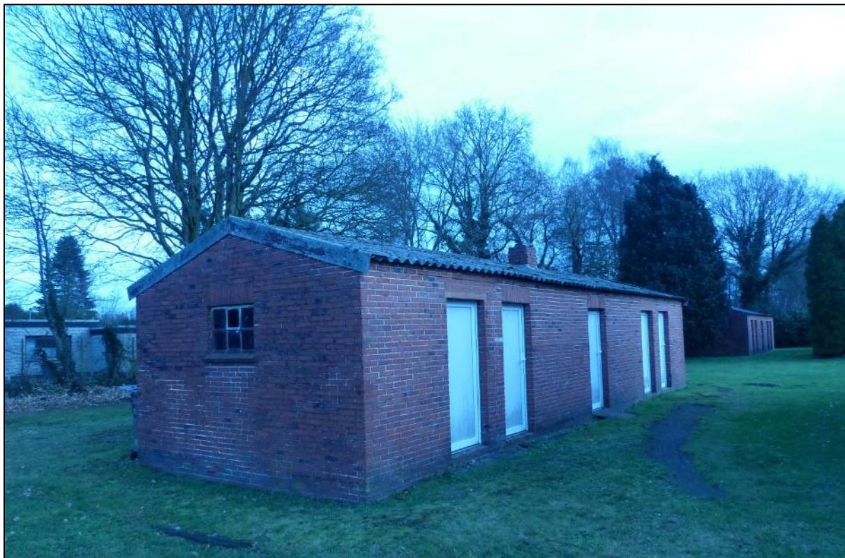
Abb. 5: Schuppen Nr. 1 (s. Abb. 13), im Hintergrund Nr. 2 und Baumbestand nördlich der Wohngebäude
